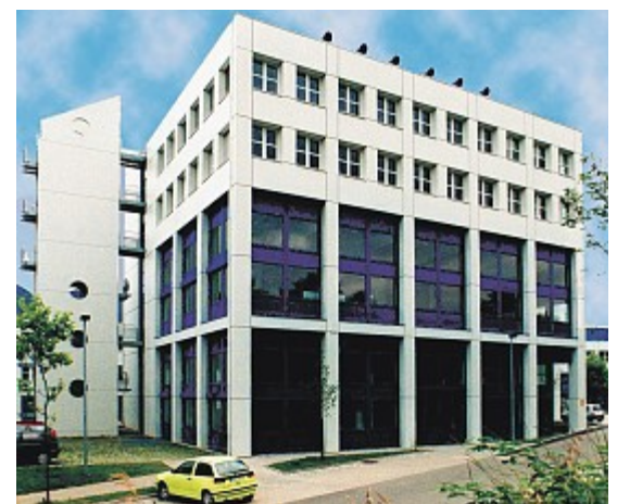
Neubau des Anwendungszentrums NMO mit zwei übereinander liegenden Werkhallen neben dem Leibniz-Institut für Neue Materialien in Saarbrücken.
